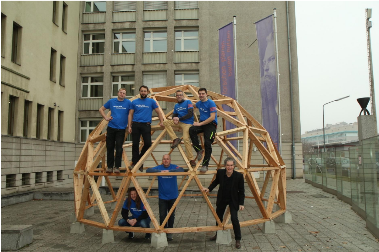
Fertige Kuppel als „temporärer Bau“ am Vorplatz der Schule in 1030 Wien Camillo Sitte Bautechnikum www.bautechnikum.at
