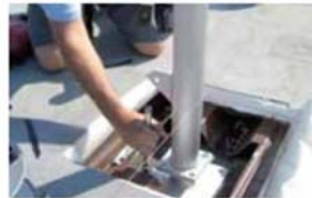
Setzen der Konsole
