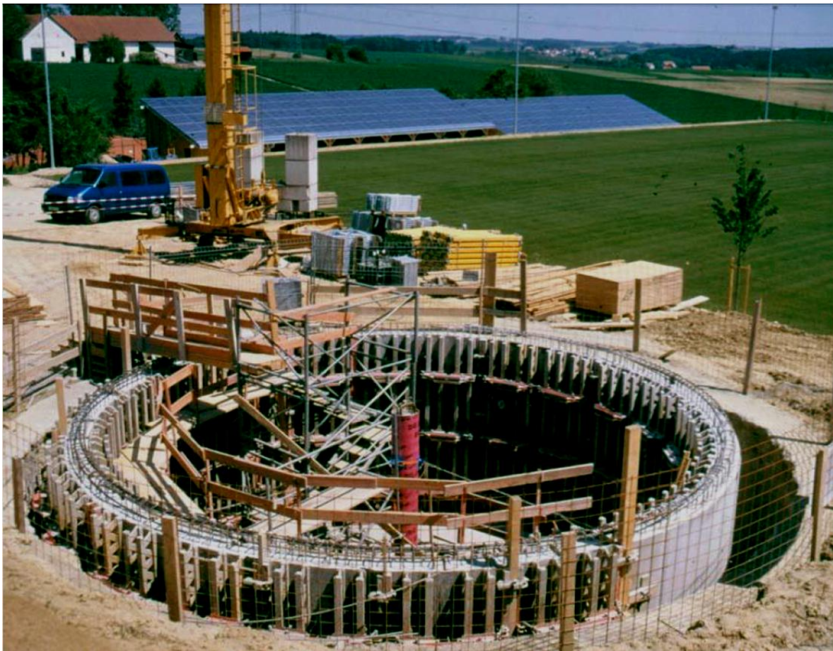
Abb. 2-38: Bau des Erdbeckenspeichers, im Hintergrund die Solaranlage auf den Sommerstockbahnen (Reuß, 2009)
