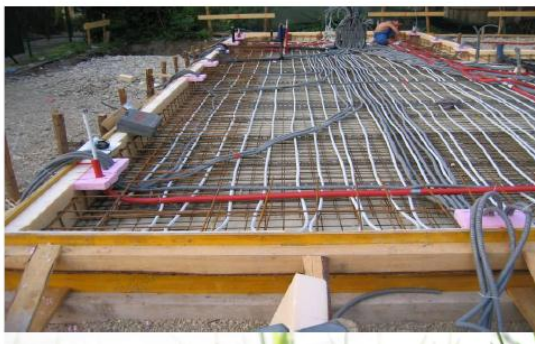
Abb. 2-30: Arbeitsschritte bei der Bodenplattenaktivierung (Ferle, 2008)
