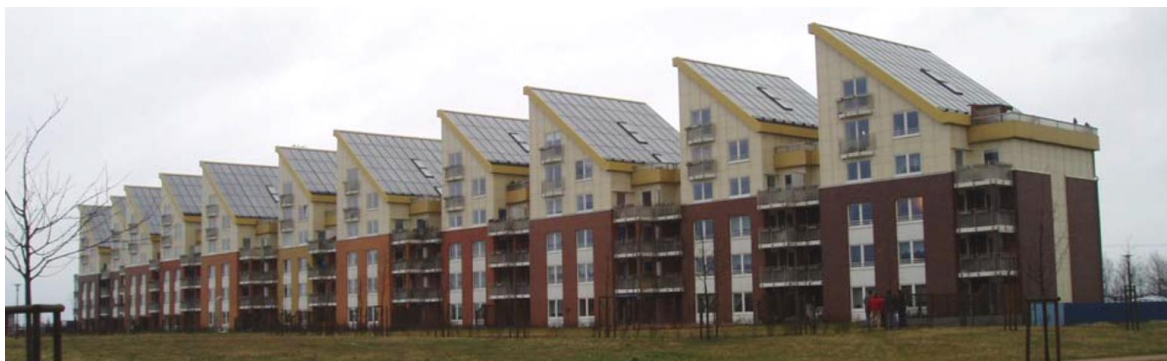
Abb. 2-7: Solar unterstützte Nahwärmeversorgung in Rostock-Brinckmanshöhe (Schmidt & Müller-Steinhagen, 2004)
