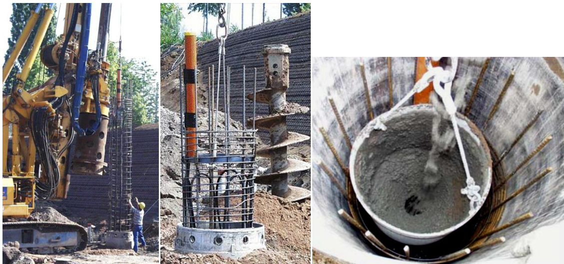
Abb. 2-10: Einbringen der Pfahlbewehrung und Betonieren (Adam, 2007)
