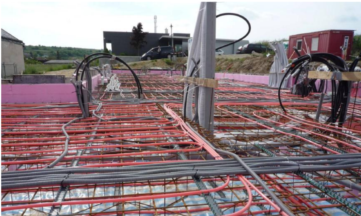
Abb. 2-34: Wärmetauscher - Ebene 3 (Ferle, 2008)
