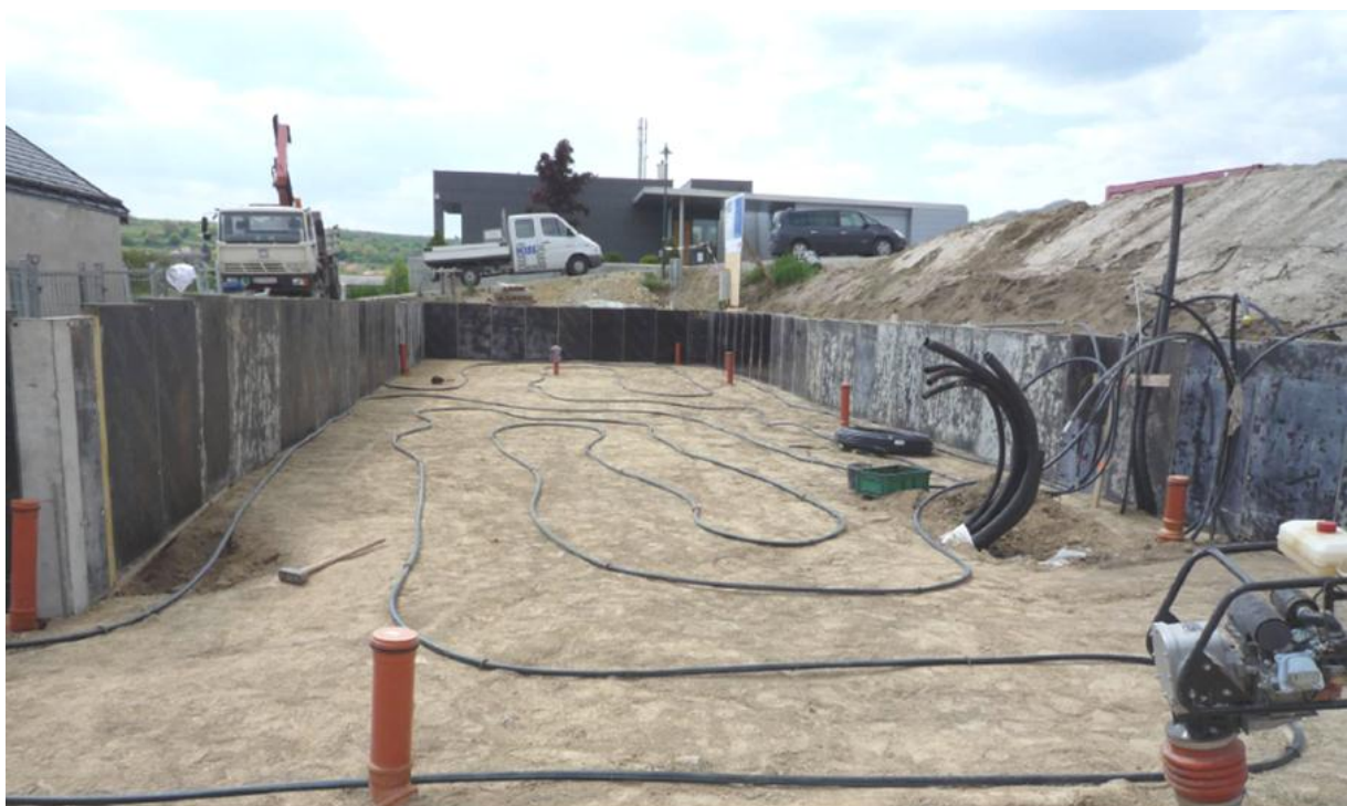
Abb. 2-31: Wärmetauscher - Ebene 1 (Ferle, 2008)
