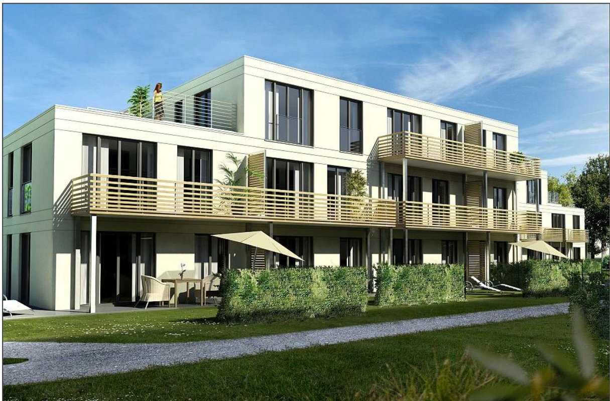
Abb. 2-39: Appartementwohnanlage KUBOX Oldenburg, Norddeutschland (Bongard, 2010)
