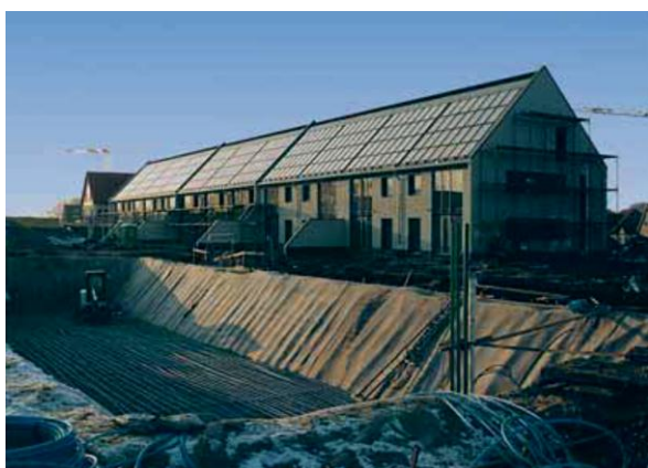
Abb. 2-24: Der Wärmespeicher im Bau und fertiggestellt (Energie Agentur.NRW, 2008)
