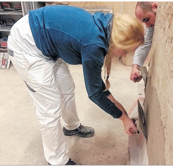
Danach beim Verputzen der Mauer. Fotos: privat
